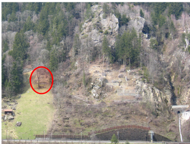
Fig. 20: ouvrages de stabilisation de la pente des CFF datant des années 1900 : à gauche, groupe d'ouvrage, à droite, ouvrage isolé. (source : SBB AG : Ingenieurbau und Umwelt, Natur und Naturrisiken)
